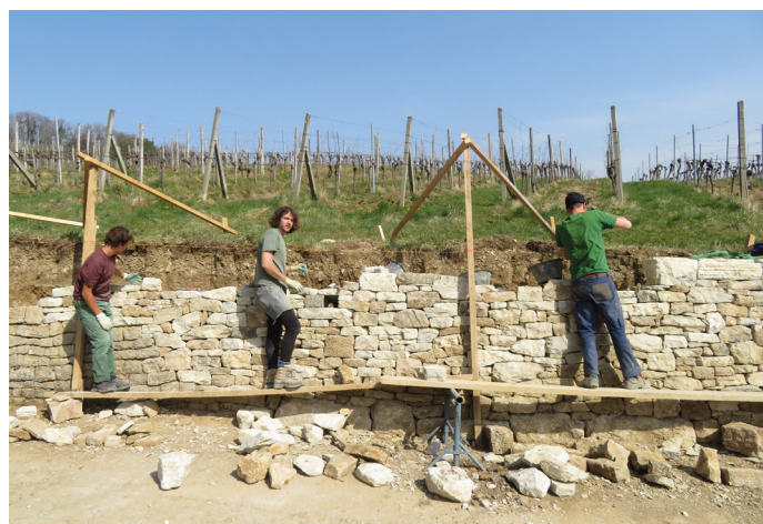
Trockenmaurer sanieren die Mauer an der Alten Gasse © Jurapark Aargau
