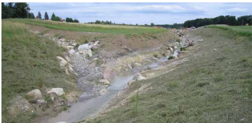
Direktbegrünung mit der Heugrassaat-Methode entlang eines renaturierten Bachlaufes und auf einer Wegböschung.
