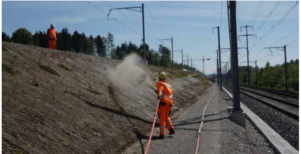
Mit Hydrosaat (Anspritzverfahren) kann Heudrusch-Saatgut auch auf steilen und grossen Flächen ausgebracht werden. Alle Fotos: A. Bosshard
