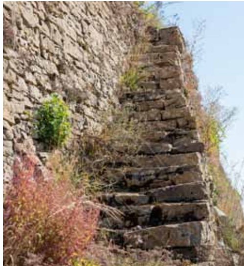
Jahundertealte Steintreppe in Trockensteinbau.
