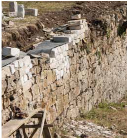
Hier wird aktuell renoviert. Stein für Stein wird passgenau in Form geschlagen und gesetzt.
