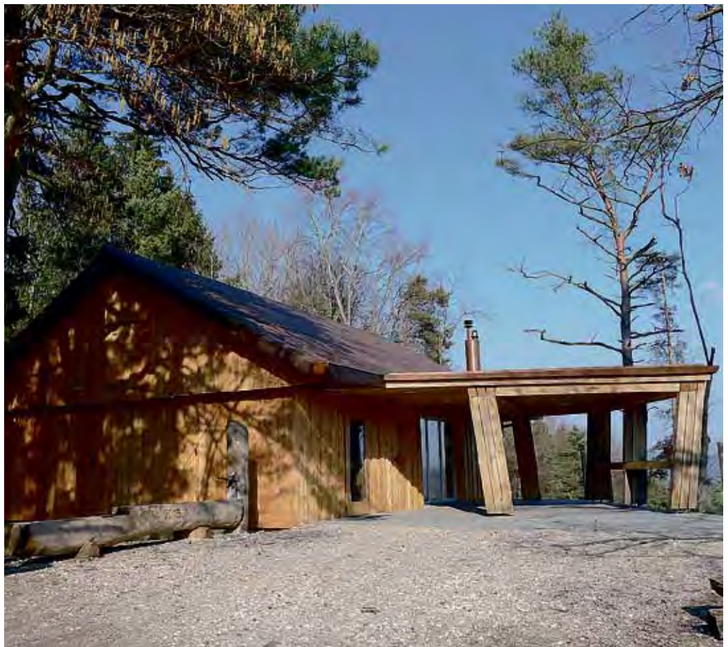
Waldhaus Thierstein. Am Innenausbau und an der Aussensanierung waren örtliche und regionale Firmen beteiligt. Die Holzarbeiten für den Anbau hat der lokale Forstbetrieb ausgeführt. Foto: Urs Treier
