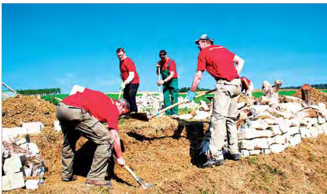
Tatkräftig am Steinlinsenbau für Reptilien und Co.
